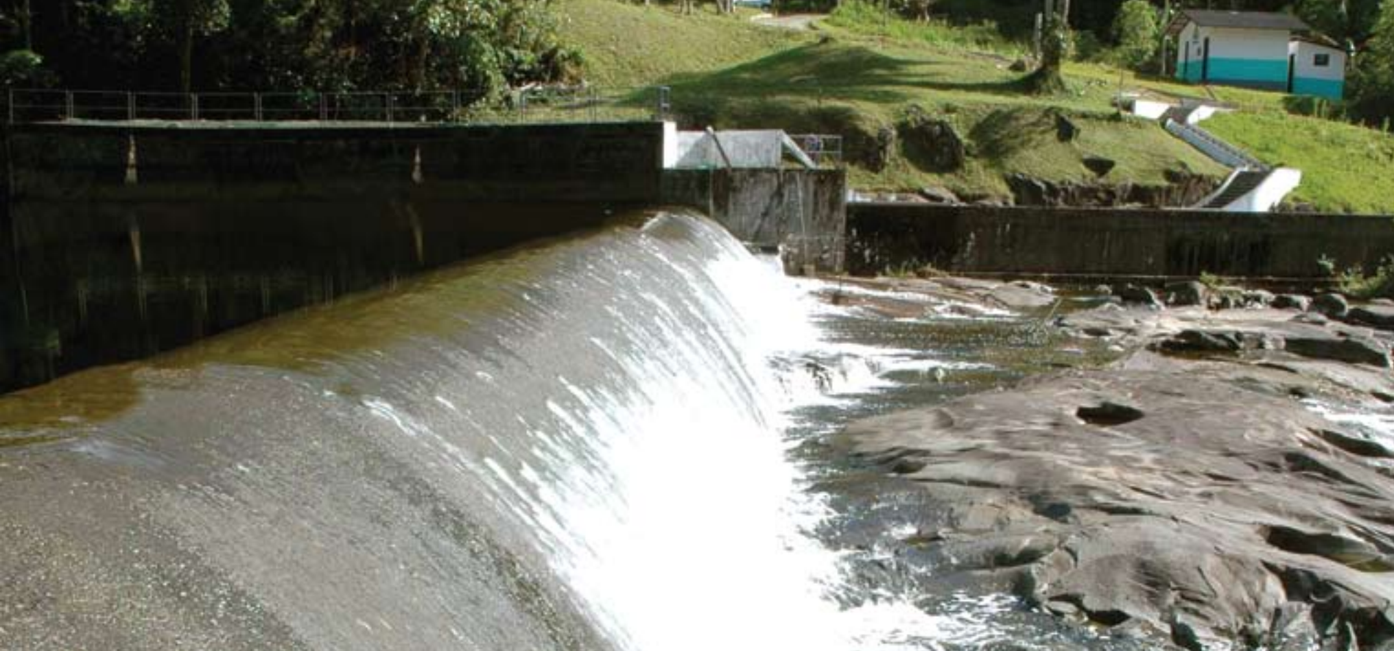
Captação de água no Rio Vargem do Braço, na Região Metropolitana de Florianópolis
